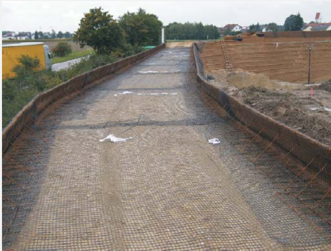
Fertigstellung einer Geogitterlage
