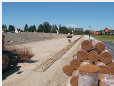
Einbau der ersten Lage
