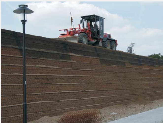
Verteilen der Schüttung
