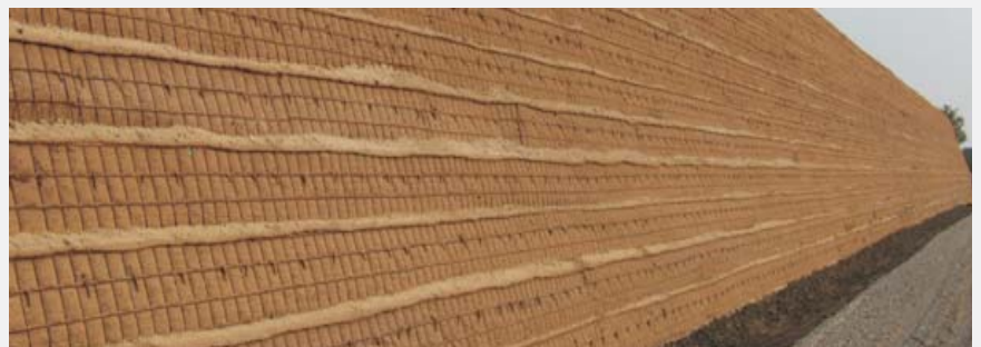
Fertiggestellte Böschung vor der Begrünung
