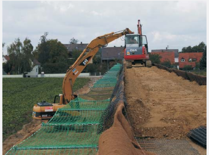
Einbringen der Schüttung
